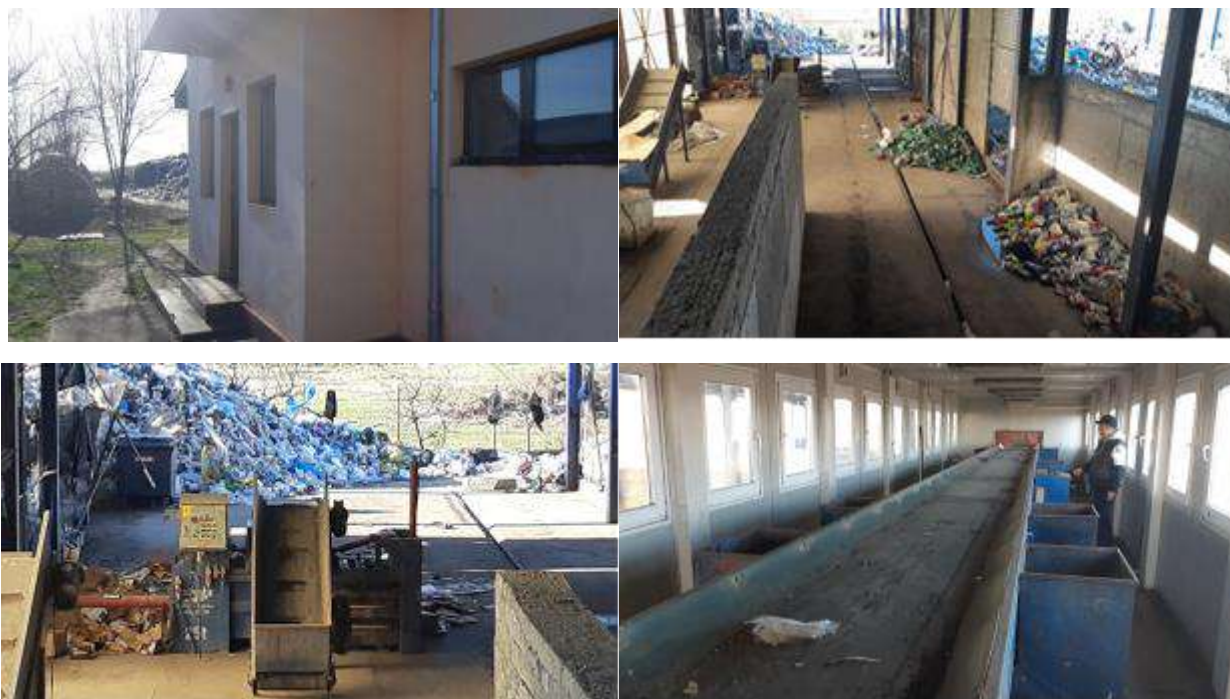
Figura 4.11. Stația de sortare a reciclabililor Drăgășani
