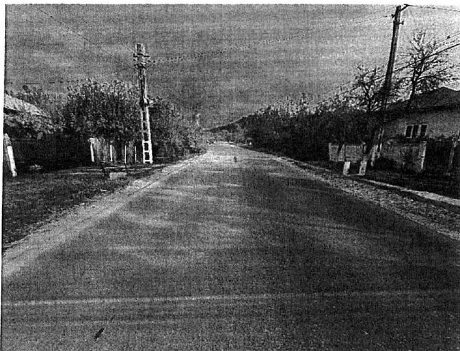
Foto 4 – Vedere în lungul DJ677A în sensul de circulație către Șirineasa, km 3+200
