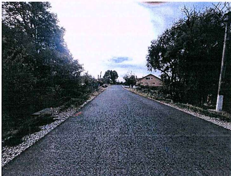
Foto 8 – Vedere în lungul DJ677A în sensul de circulație către Șirineasa, km 9+160
