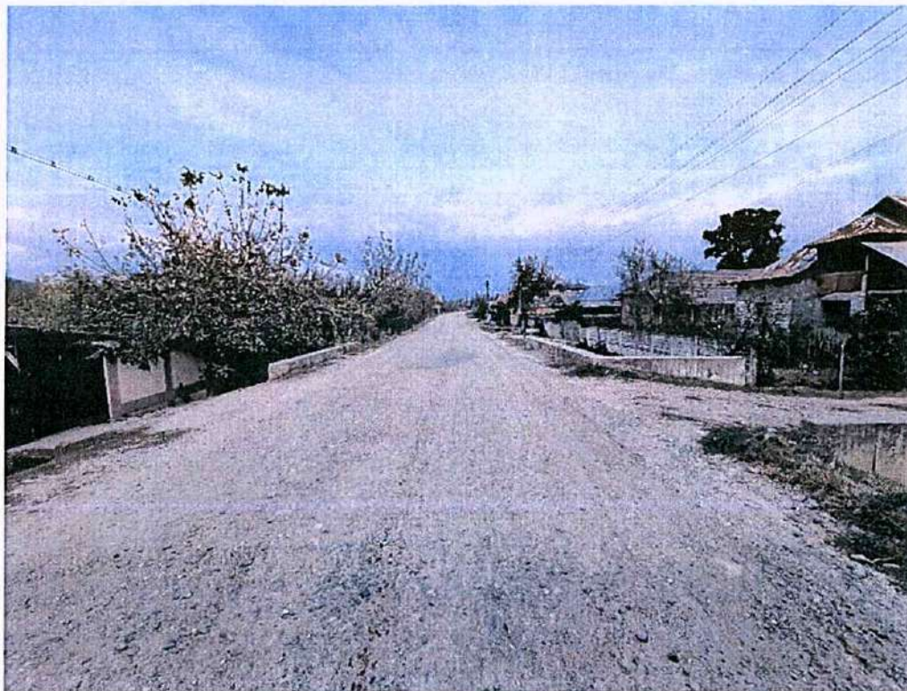
Foto 22 – Vedere în lungul DJ677A în sensul de circulație către Șirineasa, km 6+620
