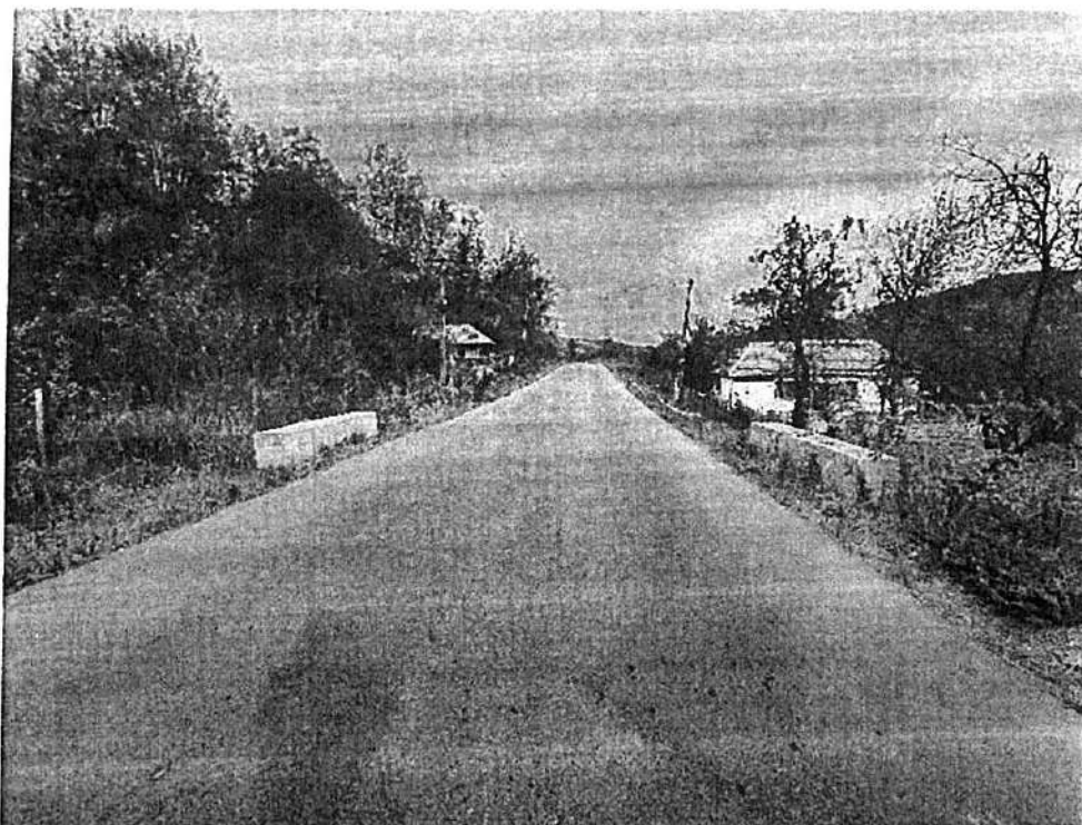
Foto 15 – Vedere în lungul DJ677A în sensul de circulație către Șirineasa, km 19+800
