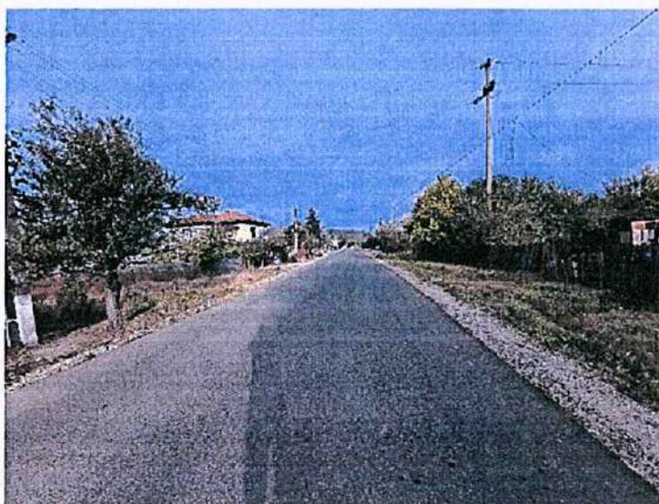
Foto 2 – Vedere în lungul DJ677A în sensul de circulație către Șirineasa, km 1+000
