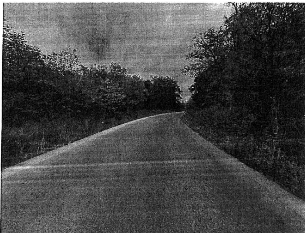
Foto 14 – Vedere în lungul DJ677A în sensul de circulație către Șirineasa, km 18+300
