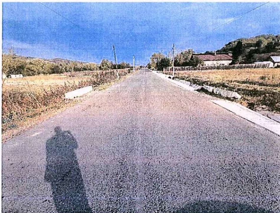
Foto 11 - Vedere în lungul DJ677A în sensul de circulație către Șirineasa, km 14+400
