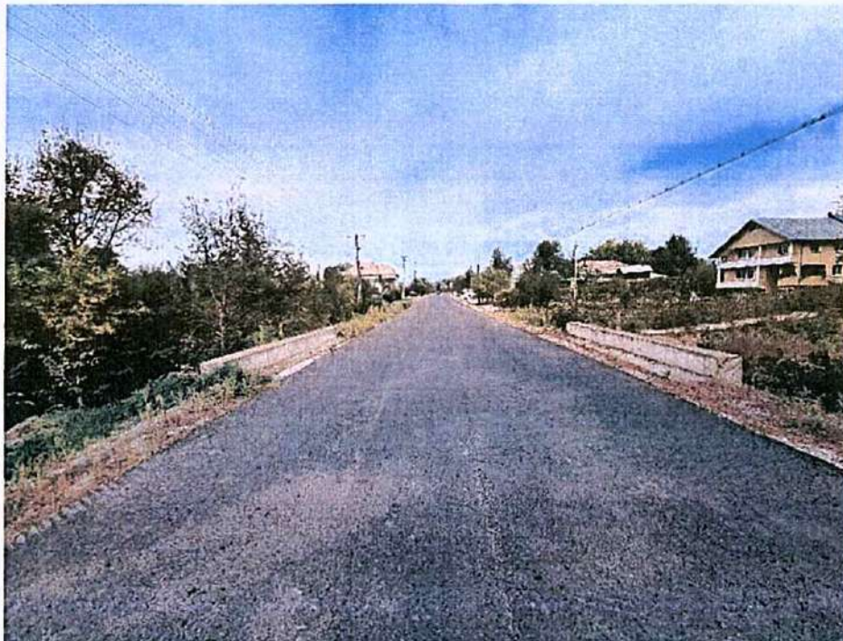
Foto 9 – Vedere în lungul DJ677A în sensul de circulație către Șirineasa, km 10+800
