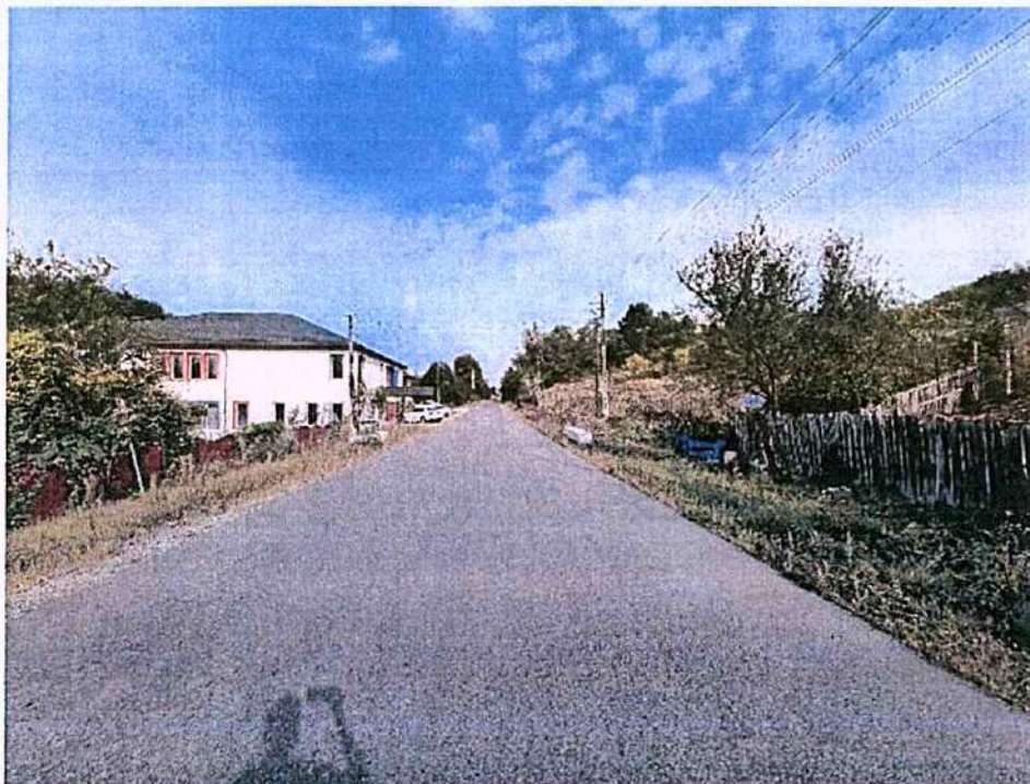
Foto 17 – Vedere în lungul DJ677A în sensul de circulație către Șirineasa, km 23+900
