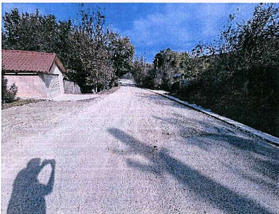
Foto 18 – Vedere în lungul DJ677A în sensul de circulație către Șirineasa, km 25+400
