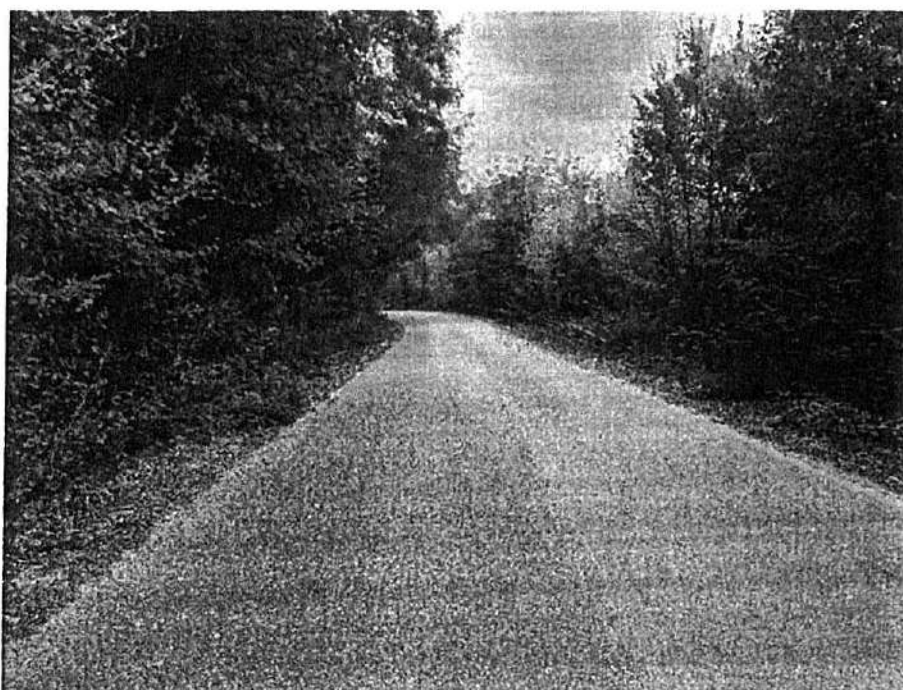
Foto 21 – Vedere în lungul DJ677A în sensul de circulație către Șirineasa, km 34+300
