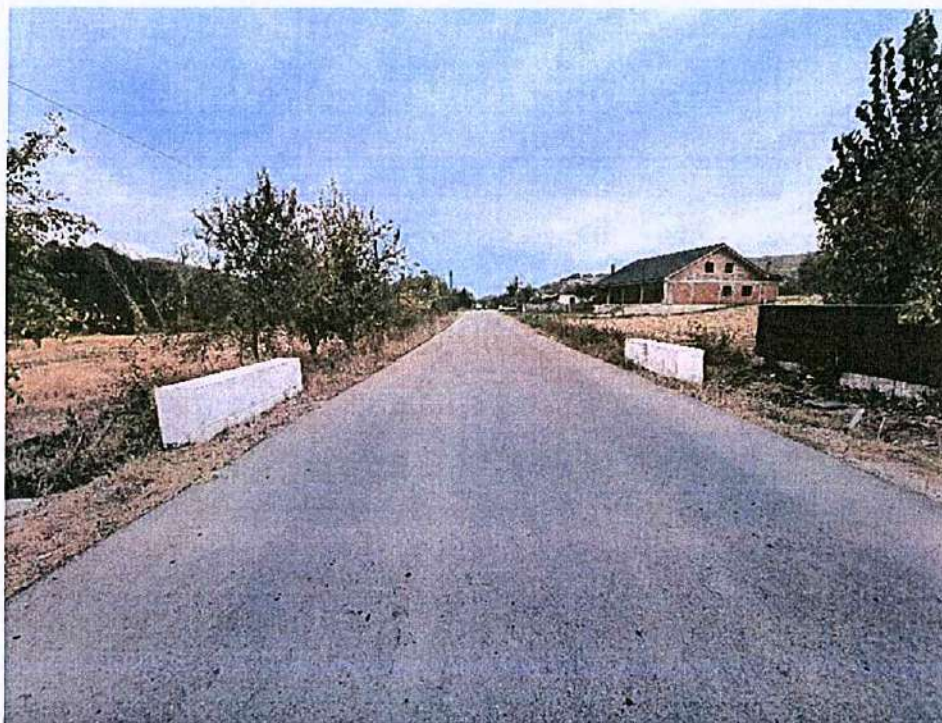
Foto 13 – Vedere în lungul DJ677A în sensul de circulație către Șirineasa, km 17+360
