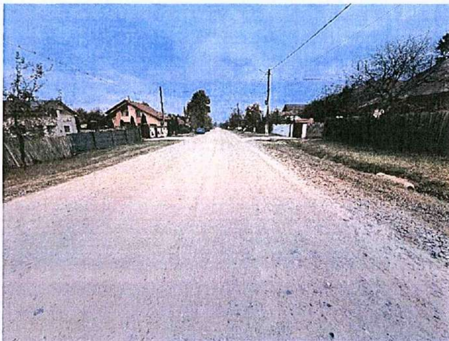
Foto 7 – Vedere în lungul DJ677A în sensul de circulație către Șirineasa, km 7+400
