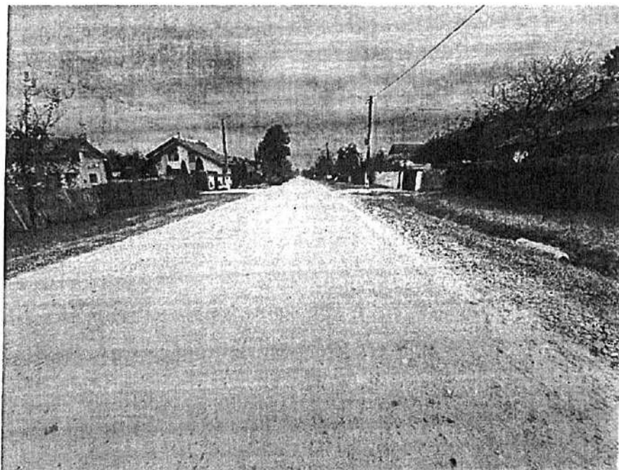
Foto 7 – Vedere în lungul DJ677A în sensul de circulație către Șirineasa, km 7+400
