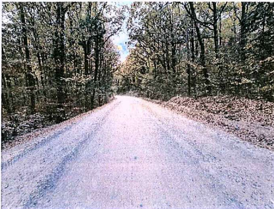
Foto 19 – Vedere în lungul DJ677A în sensul de circulație către Șirineasa, km 31+000
