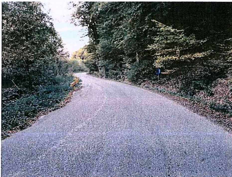
Foto 20 – Vedere în lungul DJ677A în sensul de circulație către Șirineasa, km 31+200
