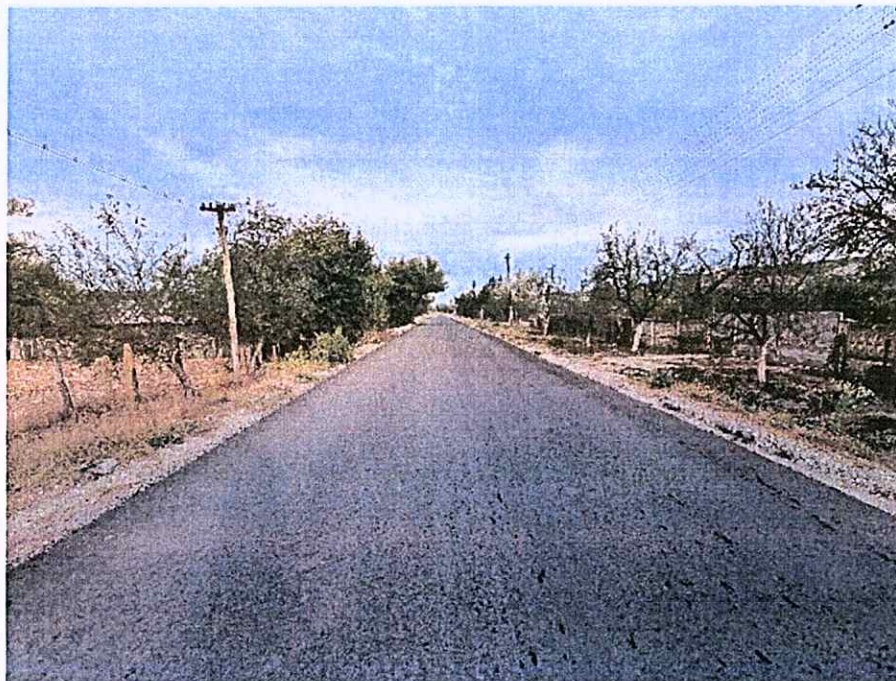
Foto 5 Vedere în lungul DJ677A în sensul de circulație către Șirineasa
