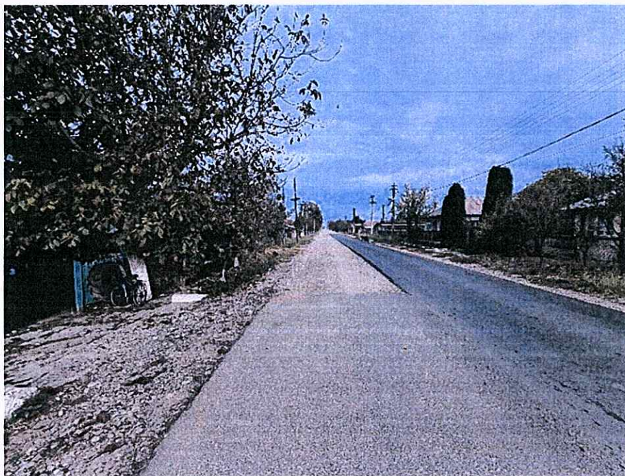
Foto 6 – Vedere în lungul DJ677A în sensul de circulație către Șirineasa
