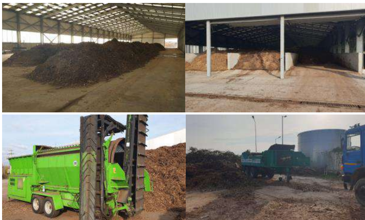
Figura 4.14. Stația de compostare Râureni
