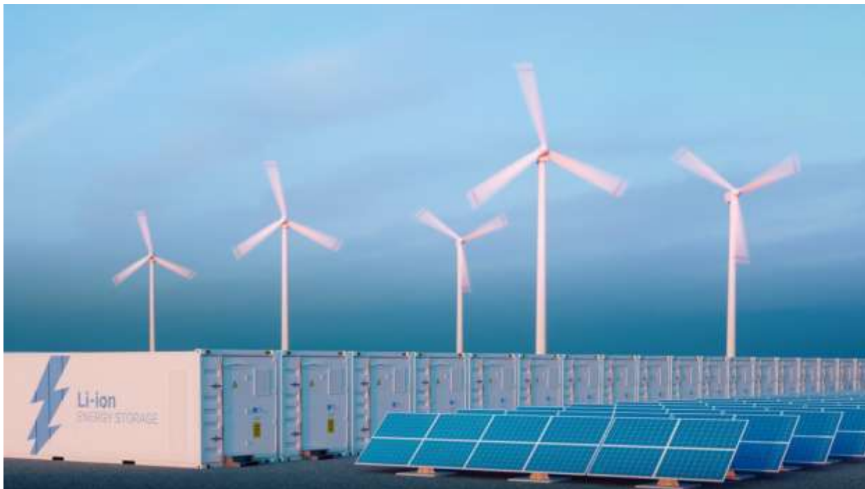
Fotografia 1. Stocarea energiei electrice
