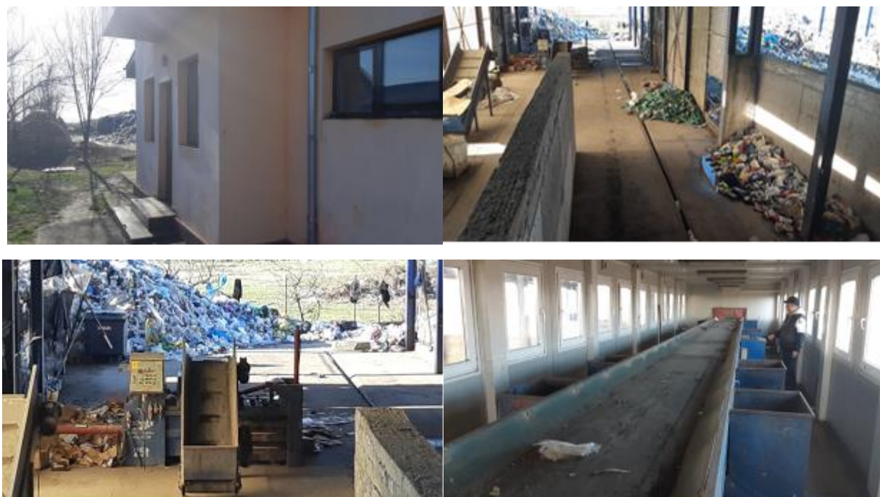
Figura 4.11. Stația de sortare a reciclabilelor Drăgășani
