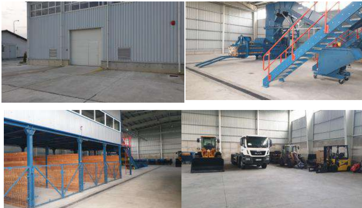
Figura 4.13. Stația de sortare Râureni
