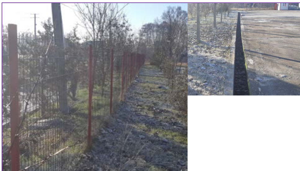
Figura 4-4: Infrastructura stației de transfer Fântărești
