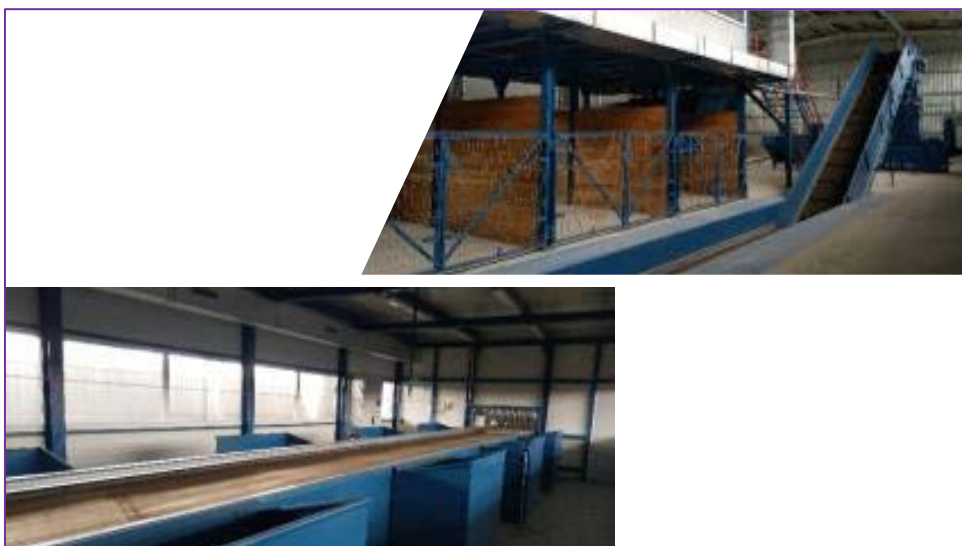
Figura 4-16: Dotări stație de sortare Râureni
