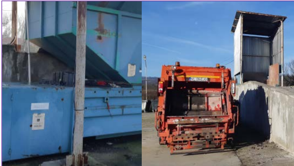
Figura 4-5: Echipamente tehnologice stație de transfer Fântățești
