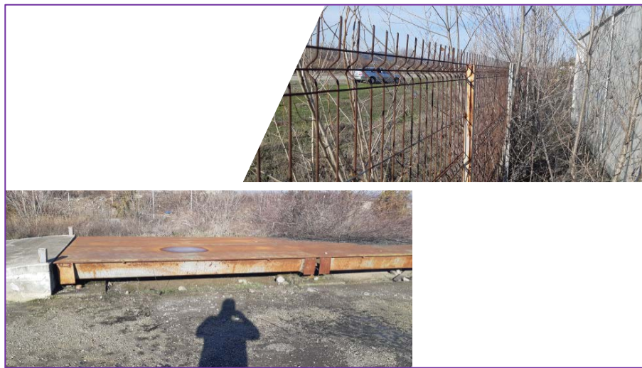
Figura 4-11: Infrastructura stației de transfer Ionești
