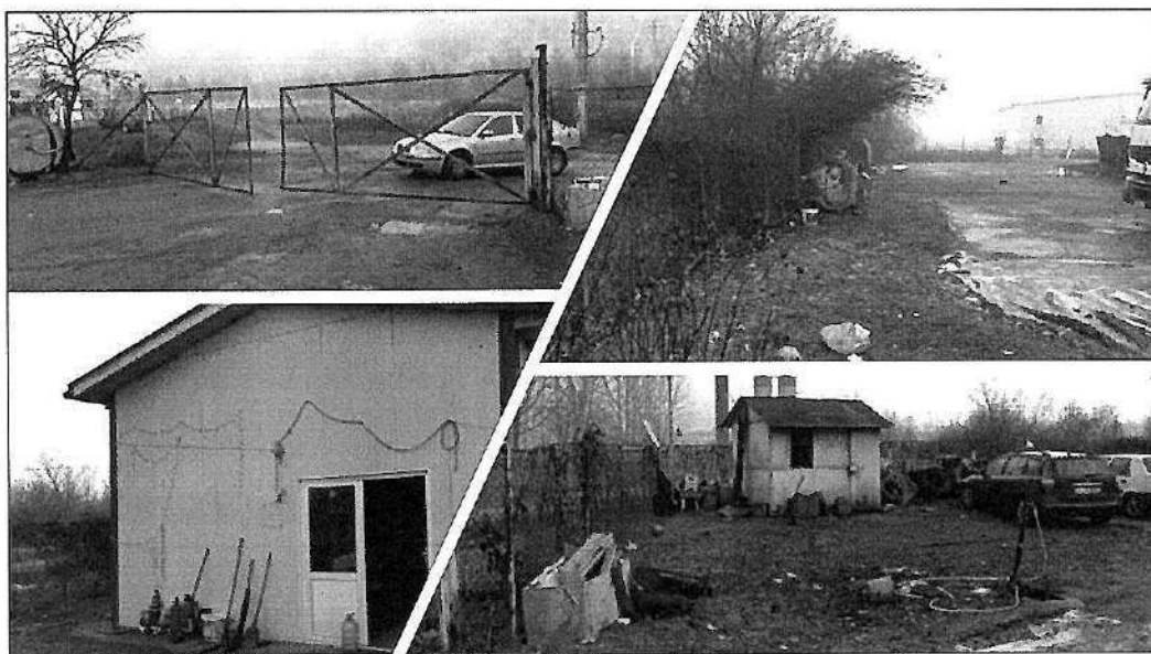
Figura 4-1: Infrastructura stației de transfer Brezoi
