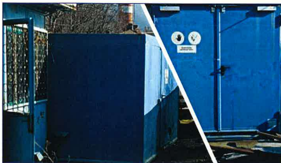
Figura 4-18: Puncte/containere de colectare deșeuri periculoase, Rm. Vâlcea
