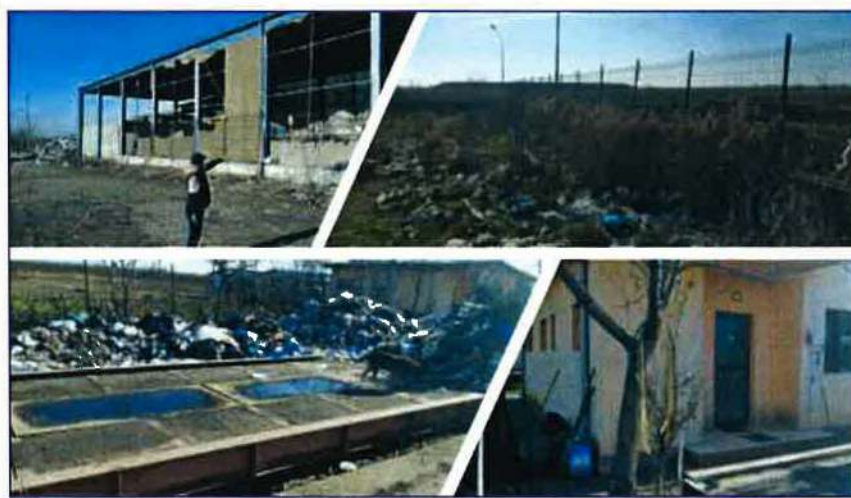
Figura 4-13: Infrastructura stației de sortare Drăgășani
