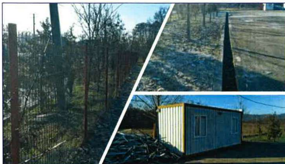
Figura 4-4: Infrastructura stației de transfer Fântărești
