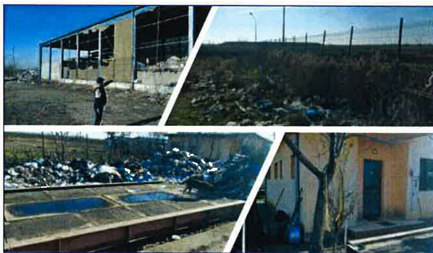
Figura 4-13: Infrastructura stației de sortare Drăgășani
