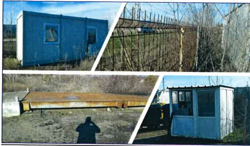
Figura 4-11: Infrastructura stației de transfer Ionești
