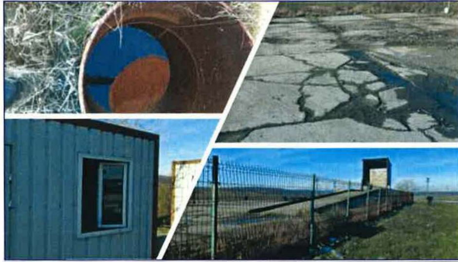
Figura 4-9: Infrastructura stației de transfer Bălcești
