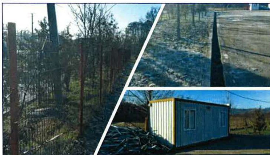
Figura 4-4: Infrastructura stației de transfer Fântărești
