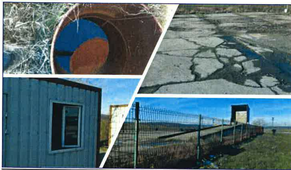
Figura 4-9: Infrastructura stației de transfer Bălcești
