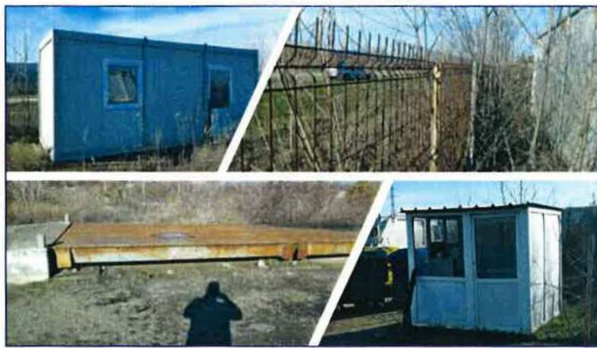
Figura 4-11: Infrastructura stației de transfer Ionești
