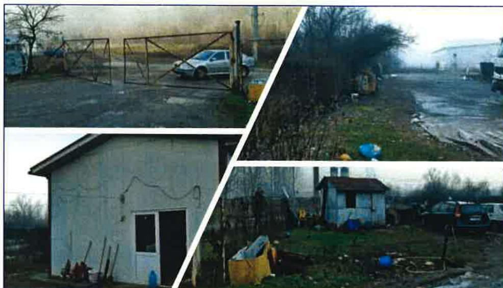
Figura 4-1: Infrastructura stației de transfer Brezoi
