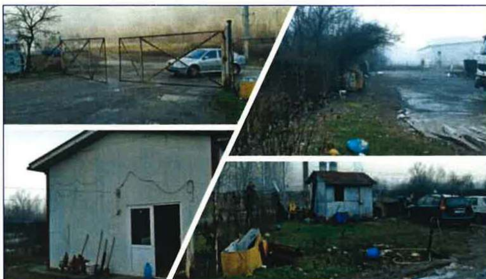
Figura 4-1: Infrastructura stației de transfer Brezoi
