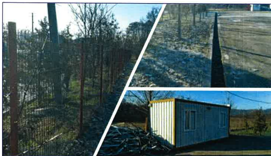
Figura 4-4: Infrastructura stației de transfer Fântărești
