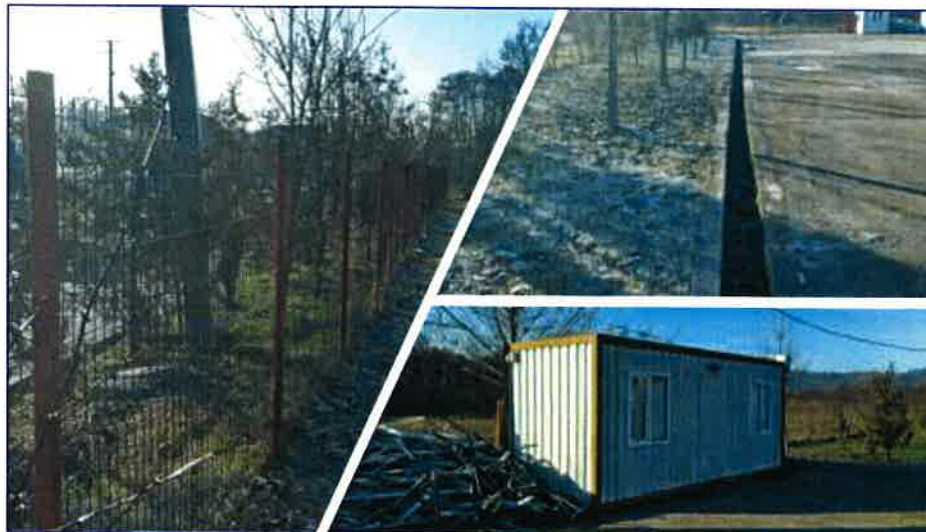
Figura 4-4: Infrastructura stației de transfer Fântățești
