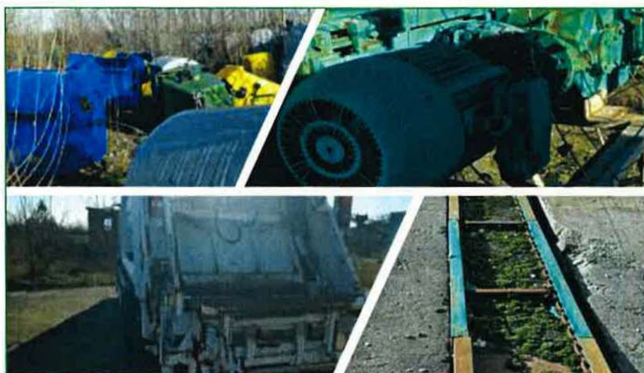
Figura 4-12: Dotări stație de transfer Ionești
