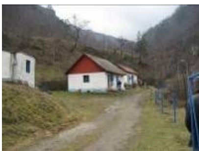
Statia de Alimentare cu Apa
