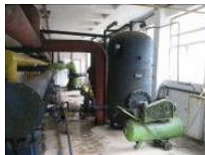
Instalatie pentru spalare in contracurent
