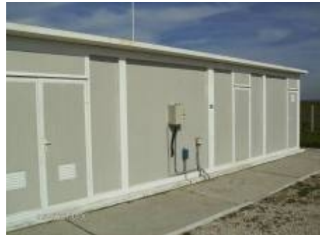
Statie de tratare a apei – incinta
