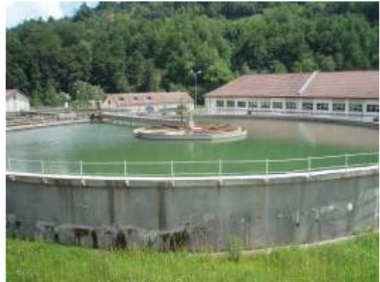
Instalatii de limpezire circulare
