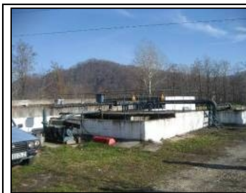
Figura2.10-57: Rezervor depozitare namol
