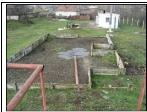
Figura 2.10-46: Paturi uscare namol
