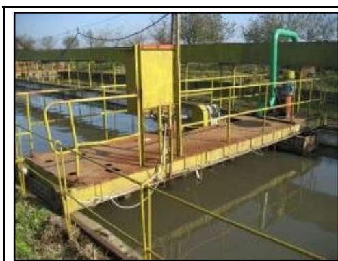
Figura 2.10-50: Decantar secundar
