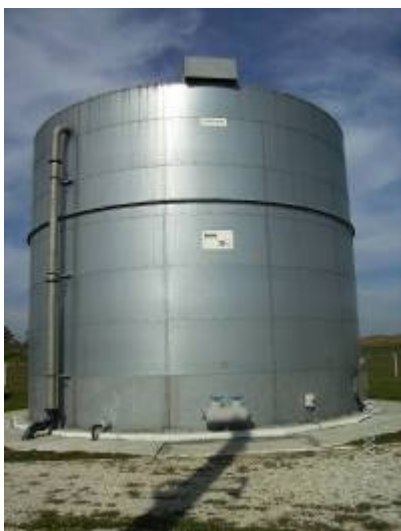
Rezervor de apa curata din otel 600m 3
