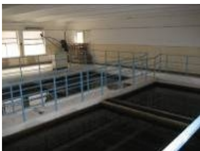
Bazin de sedimentare si filtre
