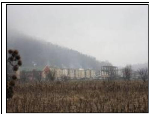
Figura 2.10-40: Vedere de la WWTP spre Alunu
