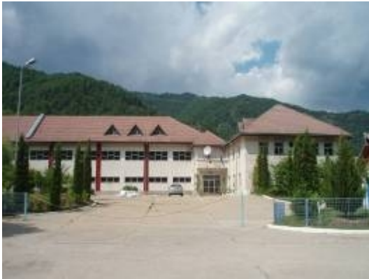
Cladirea de filtrare si cea administrativa
