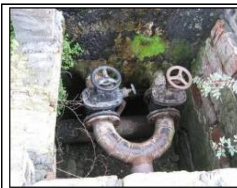
Figura 2.10-43: Conducte evacuare namol
