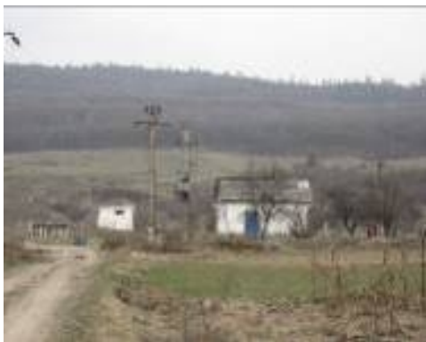
Statia de Alimentare cu Apa - Clorinare
