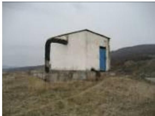
Captare din apropierea raului
