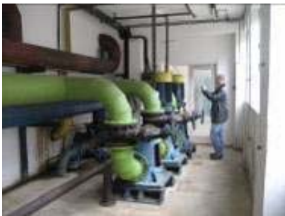
Pompe de spălare în contracurent
