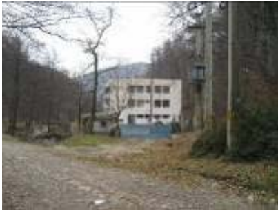
Stația de tratare
