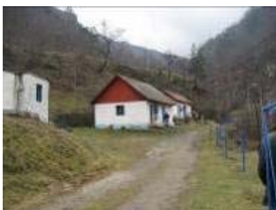
Statia de Alimentare cu Apa
