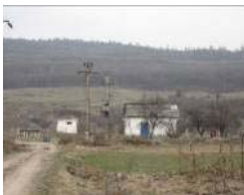
Statia de Alimentare cu Apa - Clorurare
