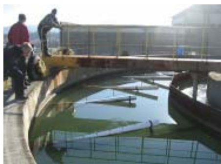
Rezervor de sedimentare (floculare)
