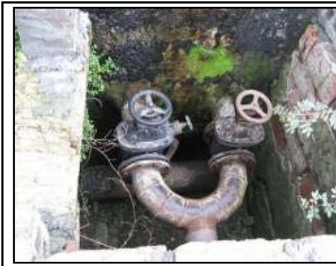
Figura 2.10-13: Conducte evacuare namol
