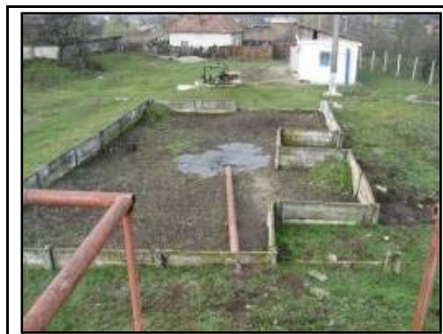
Figura 2.10-16: Paturi uscare namol
