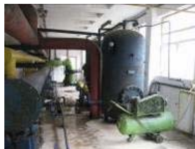
Instalație pentru spălare în contracurent
