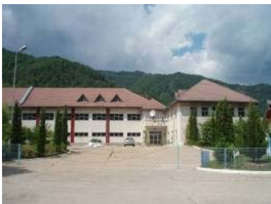
Cladirea de filtrare si cea administrativa
