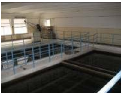
Bazin de sedimentare și filtre
