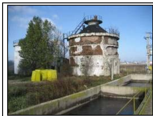
Figura 2.10-23: Paturi uscare namol Figura 2.10-24: Instalatie de fermentare demodata
