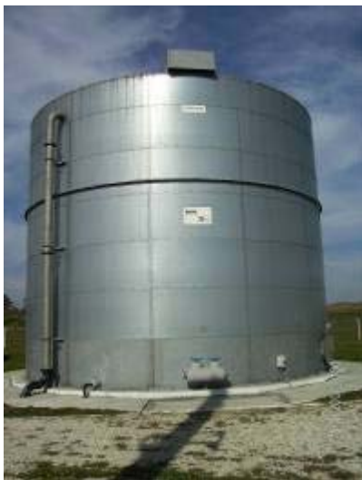
Rezervor de apa curata din otel 600m3
