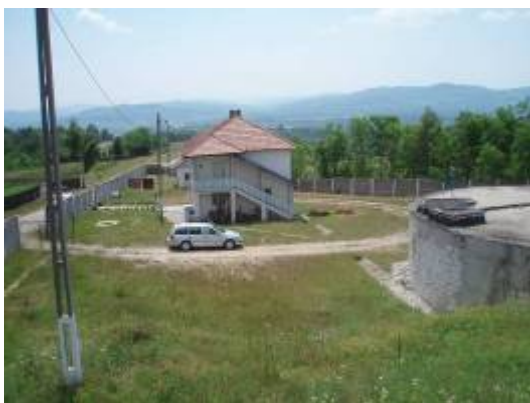
Cladirea operativa si Laborator
