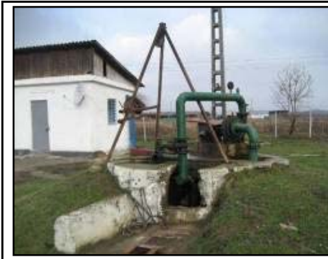
Figura 2.10-11: Statie pompare influent
