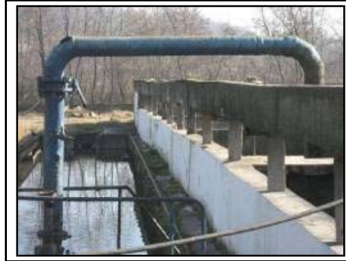
Figura 2.10-28: Decantor de nămol de retur
