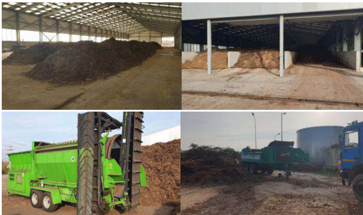
Figura 3.53. Stația de compostare Râureni
