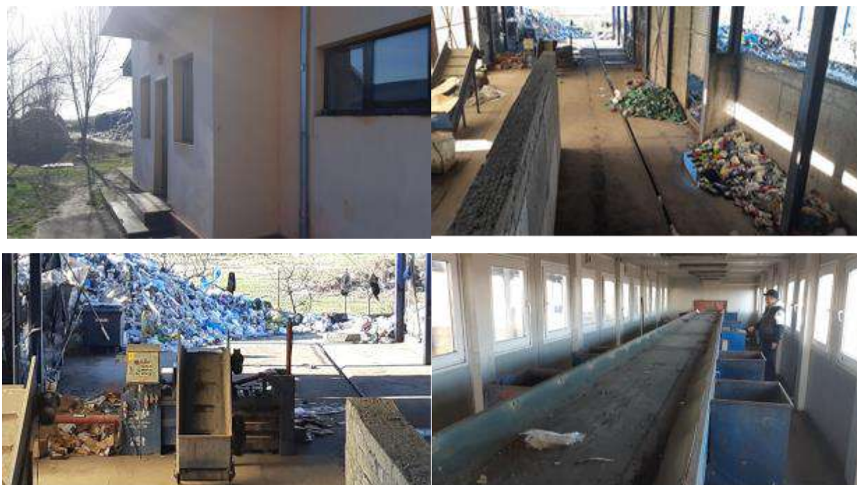
Figura 4.11. Stația de sortare a reciclabilelor Drăgășani
